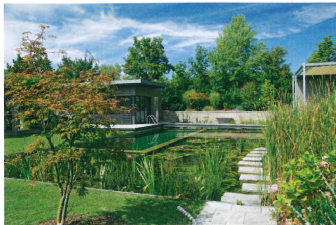
▲ Die Regenerationszone ist in zwei Bereiche aufgeteilt, den Bio-Pflanzenfilter und die Unterwasserpflanzenzone.
